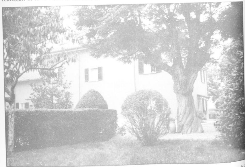
Foto 4.6 - Cascin-na (lato nord-ovest). Spinetta Marengo, edificio in terra battuta ancora abitato; all'interno le pareti e il soffitto della sala sono riccamente decorate. La costruzione è vincolata.
