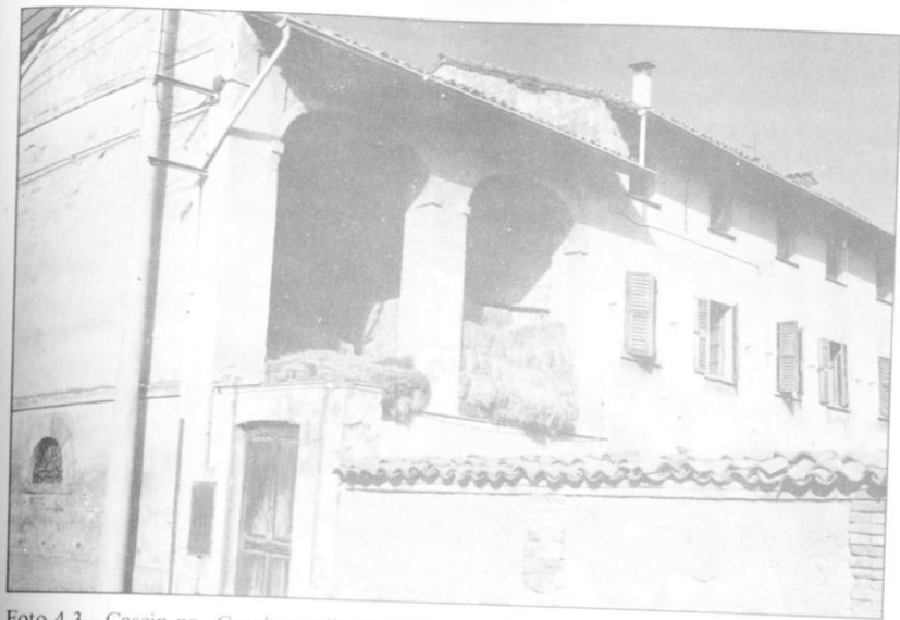
Foto 4.3 - Cascina. Casalcermelli, l'edificio è realizzato in mattoni cotti e mattoni crudi. Nella parte adibita ad abitazione vi è il sottotetto abitabile.
