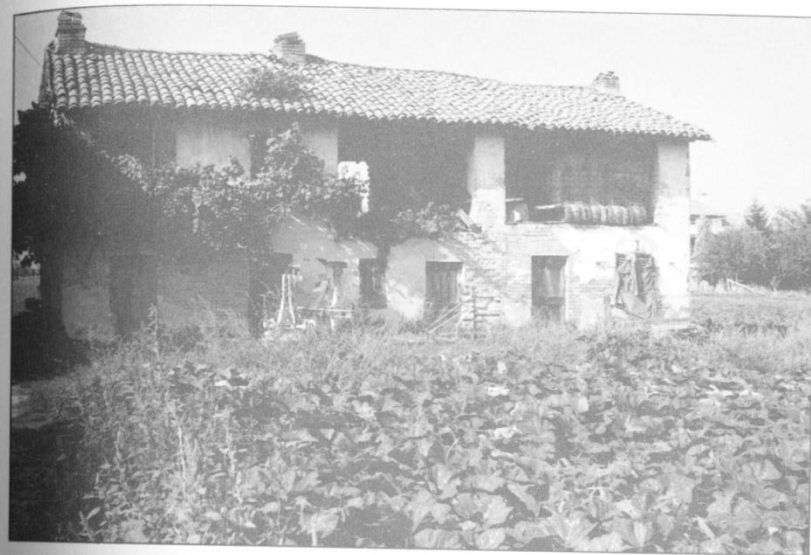
Foto 4.2 - Cascinòt. Casalcermelli, i mattoni sono disposti a corsi alternati: mattoni crudi e cotti.
