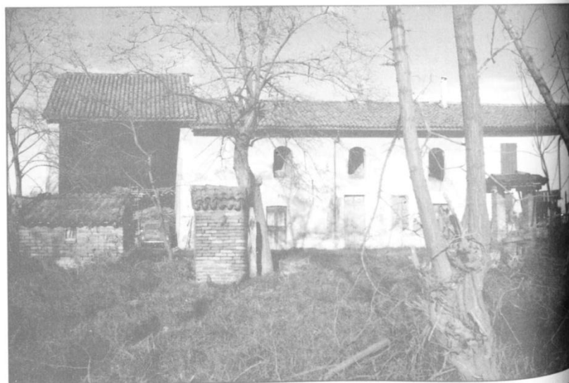
Foto 4.1 - Cascinòt. Ventolina, costruzione in terra battuta. Si notino le tipiche aperture ad arco della legnaia.
