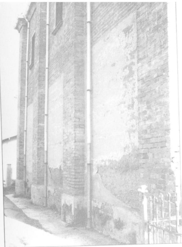
Foto 4.11 - Chiesa. Spinetta Marengo, SS. Trinità (lato ovest), questa parte della chiesa e l'abside sono realizzate in terra battuta e mattoni cotti.
