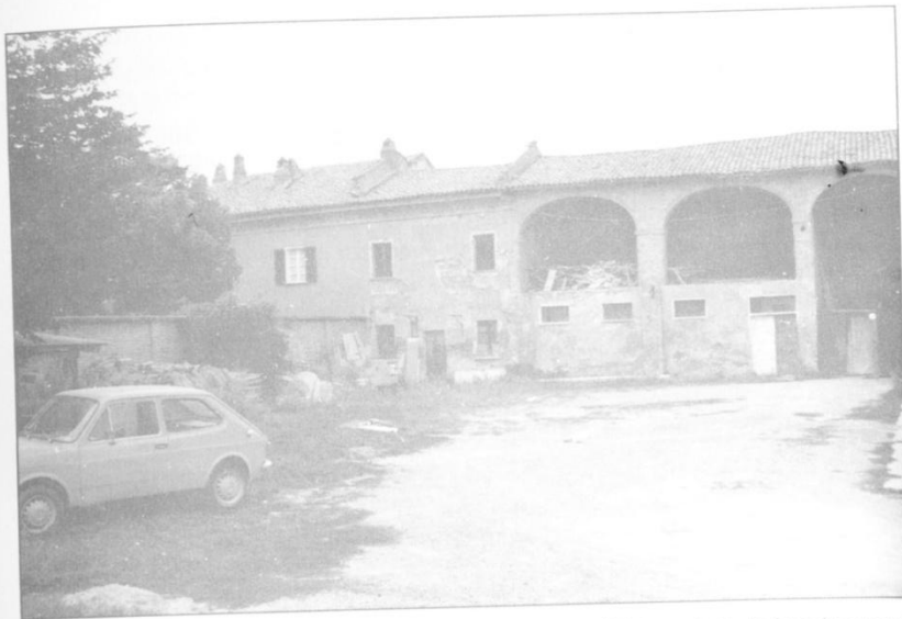
Foto 4.5 - Cascin-na (lato sud). Spinetta Marengo, sia gli edifici rurali che l'abitazione sono realizzati in terra battuta. Con pilastri in mattoni cotti. Queste costruzioni sono vincolate.
